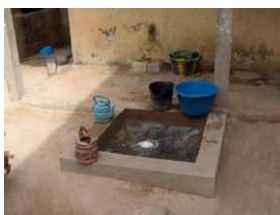
Construction de 60 puits à Yeumbeul - UFY
