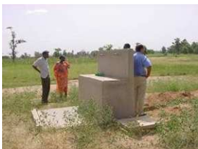
Extension du réseau d'eau potable Communauté rurale de Mboss
