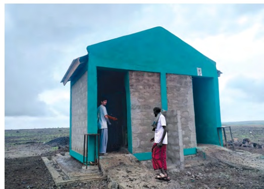
Évaluation des infrastructures d'assainissement collectives dans un site informel de déplacés internes dans le Mahi Rasu, 2025. © TGH
