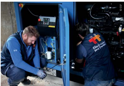
Installation de générateurs en Ukraine par l'ONG Électriciens sans frontières
