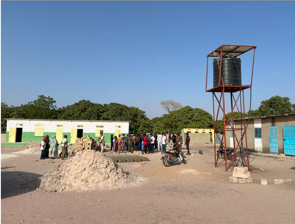
Château d'eau à Karang, Sénégal
