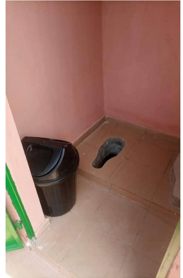
Réception des latrines à Tomety, Togo
