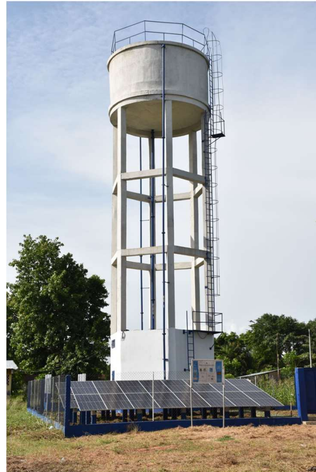
Château d'eau Bas-Mono, Togo
